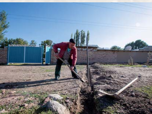
Реконструкция системы питьевого водоснабжения, Чолок-Арык
